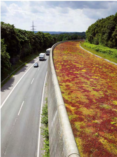
Auf der A 46 dient eine pflegeextensive begrünte Überdachung als Lärmschutz für die Anwohner und als großflächige Kompensationsmaßnahme
